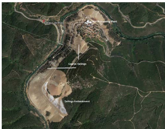
Figure 1. The tailings embankment area (Google view). Figura 1. Vista da área de la presa de relaves.
